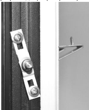
Рис. 6. Установка ригеля на POLAIR 1200
