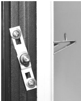
Рис. 6. Установка ригеля на POLAIR 1200
